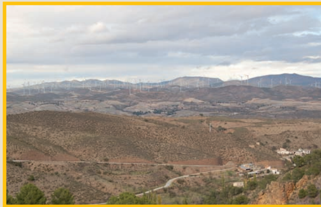
Vista del Parque eólico
