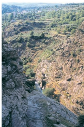
Río Trevélez y puente de La Carihuela.
